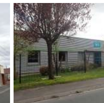
Une crèche est implantée au nord-est de la zone, elle présente une hauteur en R et est réalisée en bois et en tôle
