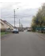
La rue Marconi est une voie tertiaire double-sens accompagnée de trottoirs et d'éclairage public
