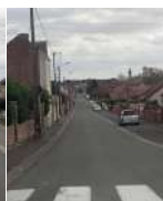
La rue J. Facq est une voie en double-sens accompagnée de trottoirs et d'éclairage public
