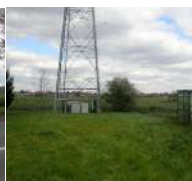
L'accès potentiel depuis la rue du Bois. Le pylône électrique représente une contrainte importante
